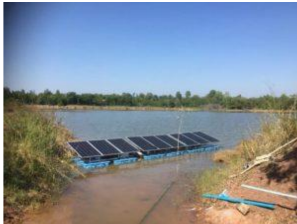
ชุมชนใช้นวัตกรรมโซลาร์เซลล์ช่วยในการสูบน้ำขึ้นไปเก็บในถังน้ำ ช่วยประหยัดค่าไฟ
