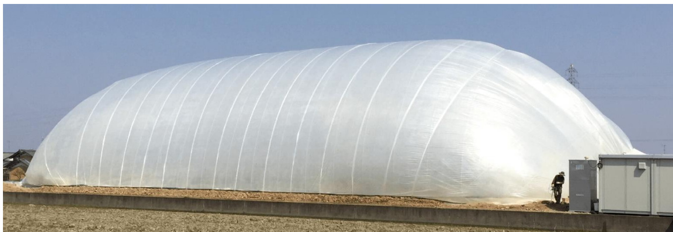
หน้าตา AIR DOME โรงเรือนปลูกผักไร้เสา (ภาพจาก LS Farm)
