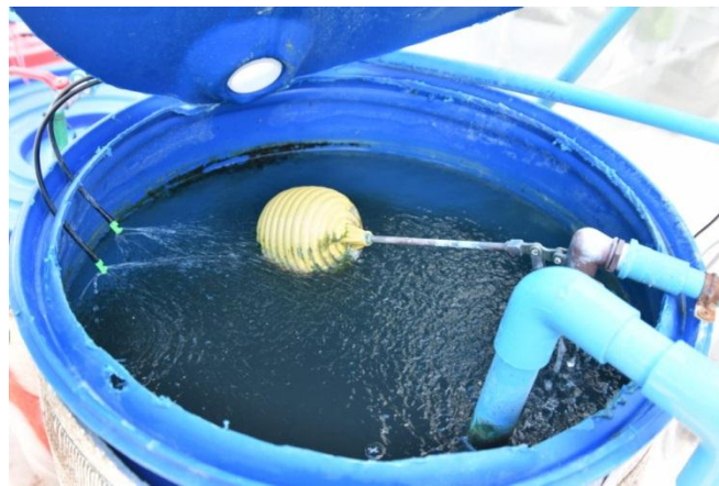
ปุ๋ย A, ปุ๋ย B จะถูกผสมในถังปุ๋ยใบที่ 3 ก่อนจะส่งไปในระบบน้ำ
