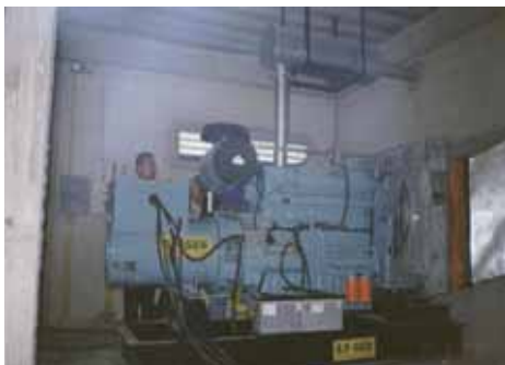
รูปที่ 3-32 เครื่องยนต์ที่ใช้ก๊าซโดยเฉพาะ (เครื่องยนต์นำเข้า) โดยต่อร่วมกับ Synchronous Generator ในการผลิตไฟฟ้า
