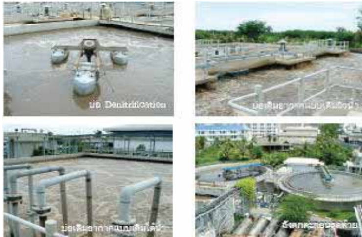
รูปที่ 5-18 ระบบบำบัดชั้นหลังแบบตะกอนเร่ง
