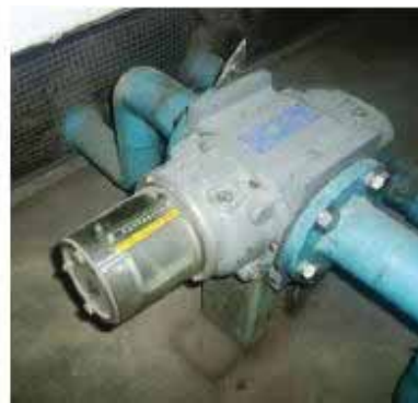
รูปที่ 5-55 เครื่องวัดอัตราการไหลของก๊าซแบบ Thermal Mass Flow Meter และแบบวัดปริมาตรของก๊าซที่ไหลผ่าน
