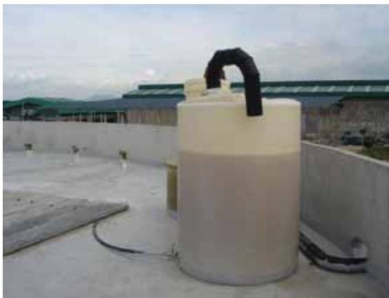
รูปที่ 3-8 โครงสร้างบ่อหมักที่เป็นบ่อก่ออิฐฉาบปูน
