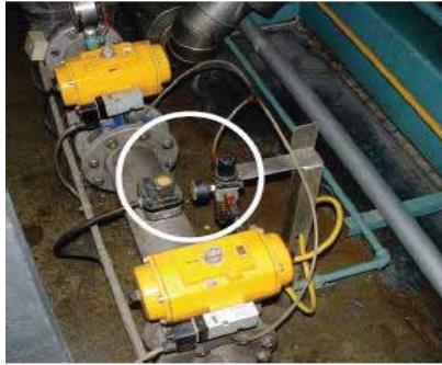
รูปที่ 5-53 Pressure Switch และรูปแบบการติดตั้ง
