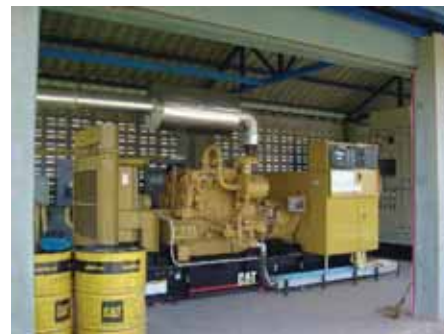
รูปที่ 3-32 เครื่องยนต์ที่ใช้ก๊าซโดยเฉพาะ (เครื่องยนต์นำเข้า) โดยต่อร่วมกับ Synchronous Generator ในการผลิตไฟฟ้า
