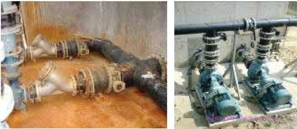
รูปที่ 5-24 ลักษณะการติดตั้งเครื่องสูบน้ำด้านข้างบ่อบำบัดน้ำ
