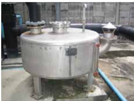
รูปที่ 3-12 ถังป้องกันความดันสูงหรือต่ำของบ่อก๊าซ
