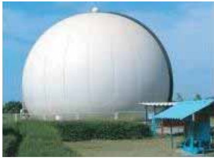
รูปที่ 3-10 โครงสร้างบ่อเก็บก๊าซชีวภาพที่เป็นวัสดุ PVC และ Membrane
