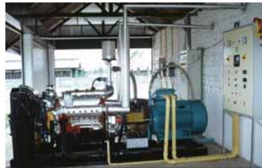
รูปที่ 3-31 เครื่องยนต์ดีเซลดัดแปลงให้ใช้ก๊าซชีวภาพแทนได้ทั้งหมดต่อร่วมกับ Synchronous/Induction Generator เพื่อผลิตไฟฟ้า
