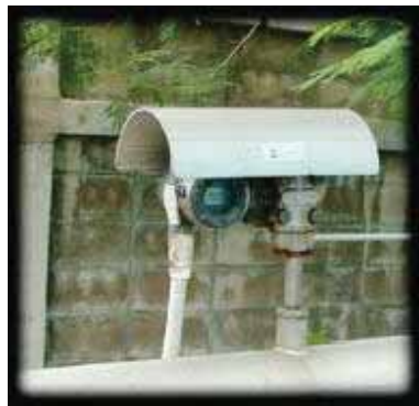
รูปที่ 5-55 เครื่องวัดอัตราการไหลของก๊าซแบบ Thermal Mass Flow Meter และแบบวัดปริมาตรของก๊าซที่ไหลผ่าน
