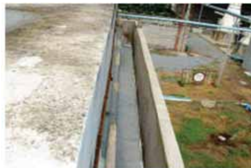
รูปที่ 5-39 น้ำออกไม่สม่ำเสมอเกิด การอุดตันของตัวกลาง/ การทรุดของเวียร์
