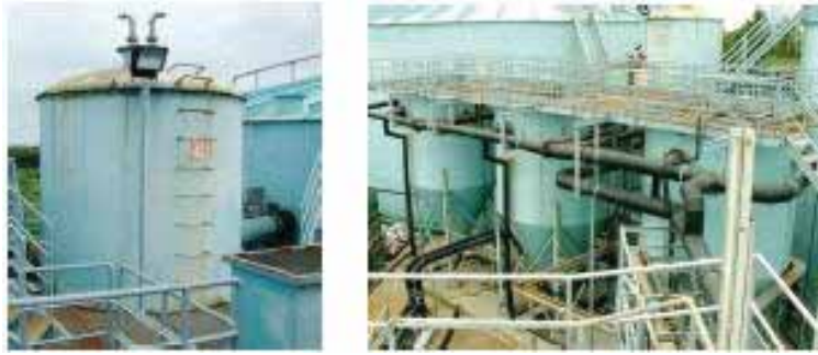
รูปที่ 5-33 ถังใส่ก๊าซและถังตกตะกอน
