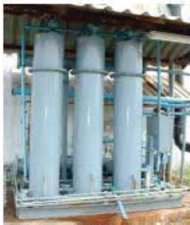
รูปที่ 5-48 ชุดกำจัดก๊าซไฮโดรเจนซัลไฟด์
