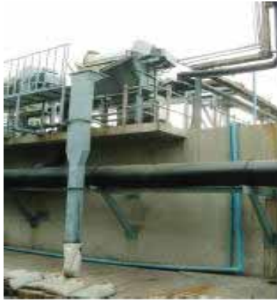
รูปที่ 5-11 การรวบรวมขยะจากตะแกรงดักขยะแบบ rotary Drum Screen
