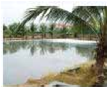
บ่อไม่ใช้อากาศ (Anaerobic Pond)
