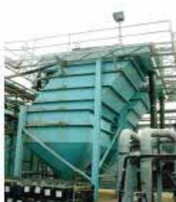
A-ถังแบบมีแผ่นเอียงช่วยตกตะกอน
