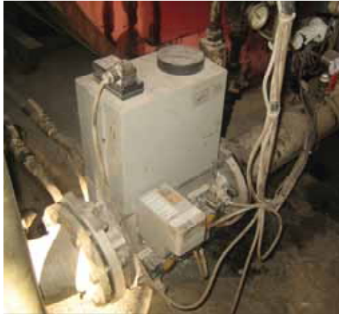
รูป Double Solenoid Valve และ Valve Proving Systems
