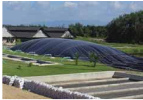
รูปที่ 3-10 โครงสร้างบ่อเก็บก๊าซชีวภาพที่เป็นวัสดุ PVC และ Membrane
