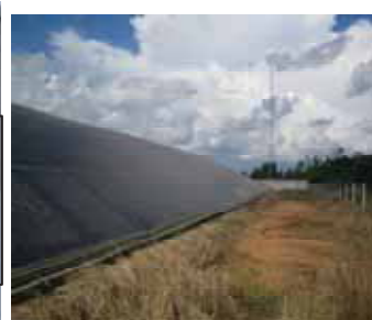
มีการระบายก๊าซส่วนเกินทิ้ง โดยวิธีเปิดชายผ้าใบข้างบ่อ ยาว~1 .0 m.
