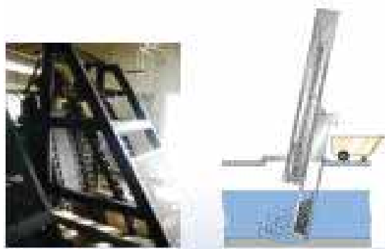
รูปที่ 5-8 ตะแกรงหยาบแบบซี่ทำงานโดยใช้ระบบอัตโนมัติ
