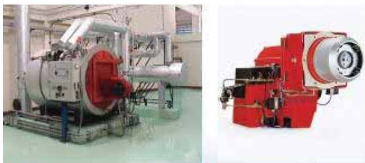
รูปที่ 5-40 เตาน้ำมันร้อน (Hot Oil Burner) และหัวเผา
