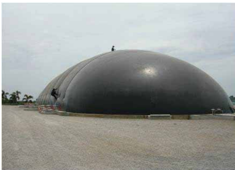
รูปที่ 1-5 ระบบ Modified Covered Lagoon ในโรงงาน
