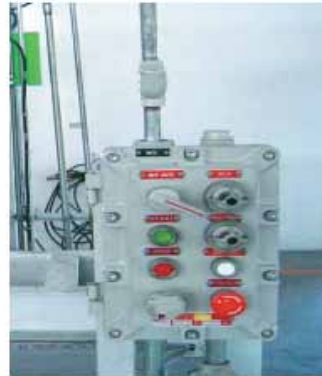
รูปที่ 3-7 การเดินท่อร้อยสายไฟในพื้นที่อันตรายอุปกรณ์ไฟฟ้าจะต้องเป็นชนิดทนระเบิด
