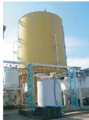
รูปที่ 3-9 โครงสร้างบ่อหมักที่เป็นถังเหล็ก
