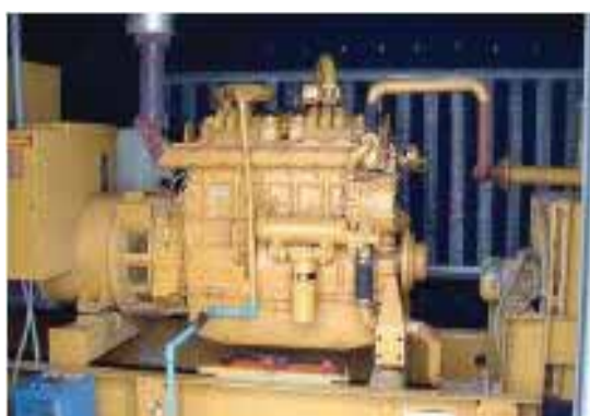
รูปที่ 5-42 ชุดเครื่องปั่นไฟใช้เชื้อเพลิงจากก๊าซชีวภาพ
