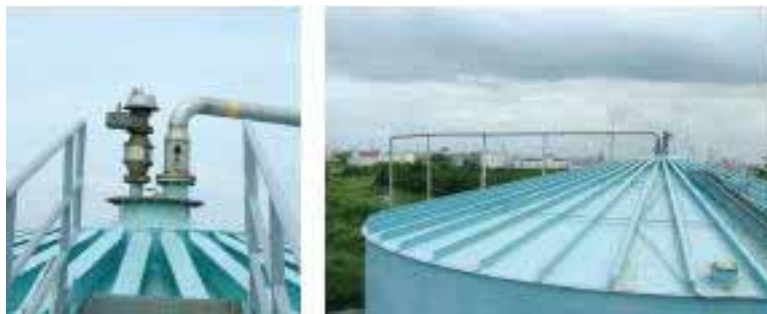
รูปที่ 5-50 การติดตั้ง Pressure Release Valve
