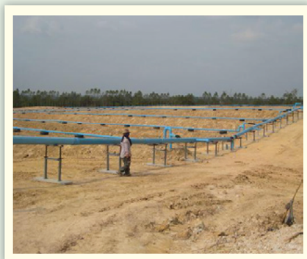
รูปแสดงการวางท่อรวมก๊าซชีวภาพและระบบฝังกลบเพื่อผลิตก๊าซชีวภาพ
