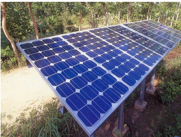
ภาพที่ 3 การนำระบบเซลล์แสงอาทิตย์มาใช้ผลิตไฟฟ้า
